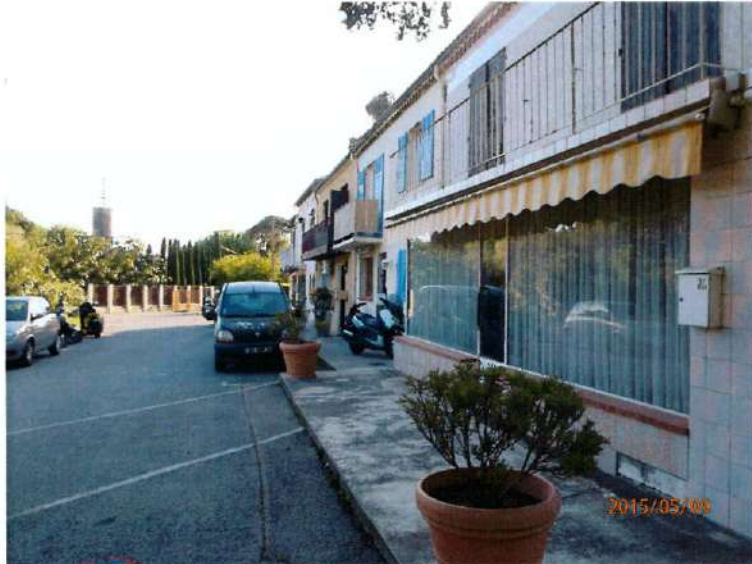
Photo n°29 : un fontis s'est formé devant ce bâtiment et a été rebouché - Quartier Fontmerle
