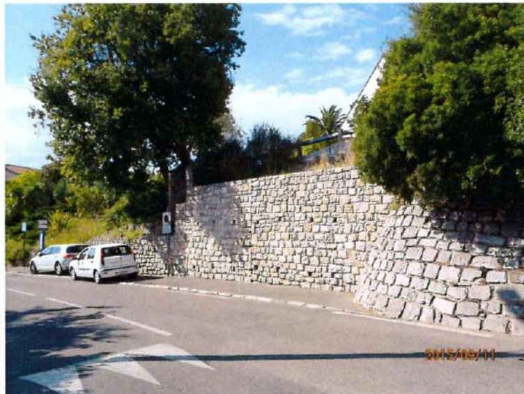
Photo n°30 : mur de soutènement du boulevard Courteline
